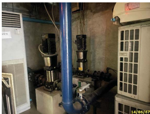
ถังเก็บน้ำ และเครื่องปั้มน้ำขึ้นใต้ดิน อาคาร C
